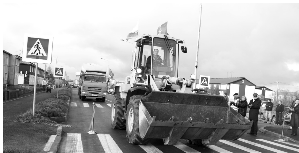
В 2016 ГОДУ ВВЕДены В ЭКСПЛУАТАЦИЮ ТРИ НОВЫЕ ДОРОГИ. ПРОТЯЖЕННОСТЬ АСФАЛЬТИРОВАННЫХ АВТОДОРОГ УВЕЛИЧИЛАСЬ ПОЧТИ НА 4 КМ.
