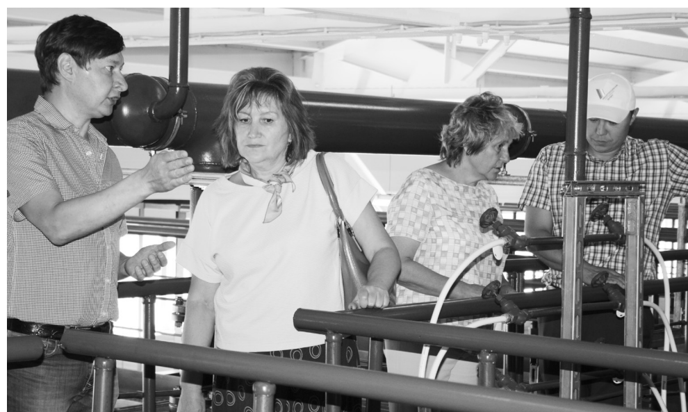
ЛЕТОМ 2016 ГОДА В ПРОЕКТНЫЙ РЕЖИМ ЭКСПЛУАТАЦИИ ВВЕДены НОВЫЕ ОЧИСТНЫЕ В КАЧГОРТЕ. К ЦЕНТРАЛЬНОЙ КАНАЛИЗАЦИИ ПОДКЛЮЧЕНЫ ЧЕТЫРЕ СОЦОБЪЕКТА, ХЛЕБОЗАВОД И 17 ЖИЛЫХ ДОМОВ.
