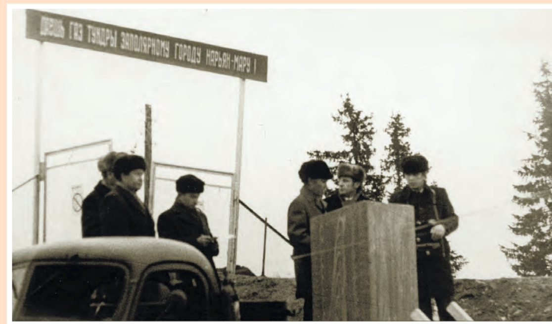
16 ноября 1978 года город подключился к Василковскому месторождению, котельные переведены с угля на газ. Первый газифицированный дом - Пионерская,6
