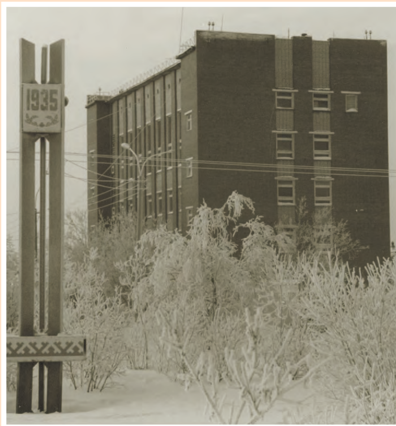
В 1975 году строители сдали первое многоэтажное здание в кирпичном исполнении — здание окружкома КПСС (ныне - здание администрации города Нарьян-Мара)
