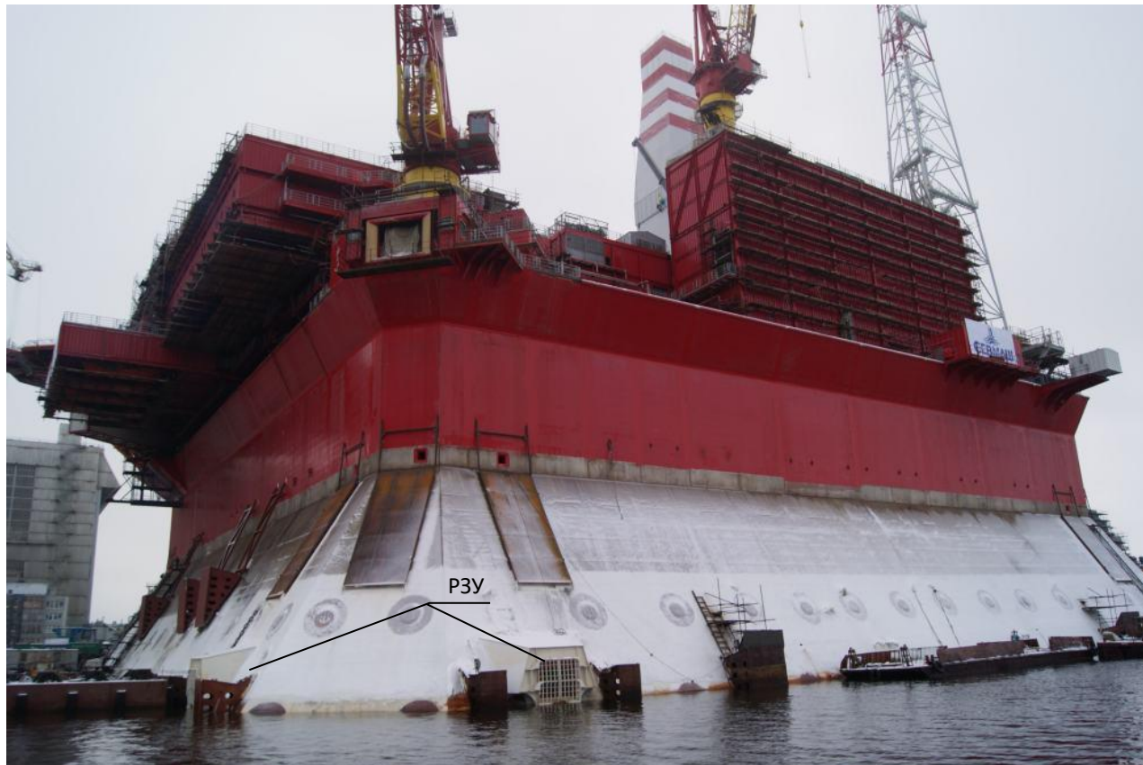
Рисунок 4.6 - Рыбозащитные устройства МЛСП «Приразломная»
